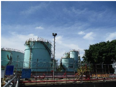
ภาพที่ 2-19 ระบบฉีบน้ำดับเพลิงบริเวณถังเก็บน้ำมัน
