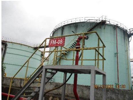
ภาพที่ 2-23 ระบบฉีดน้ำดับเพลิงแบบโฟม
